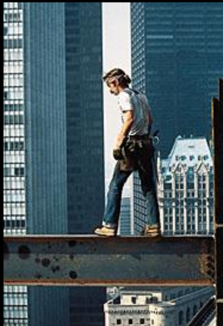
Fig. 2 – Este operário da construção civil está em equilíbrio instável.
